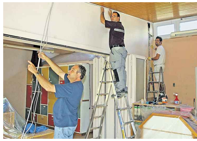
Reinhard Schromm, Elektriker Thomas Müller und Maler Lars Eisele (von links) verlegen die Anschlüsse der elektrischen Fensterheber.
